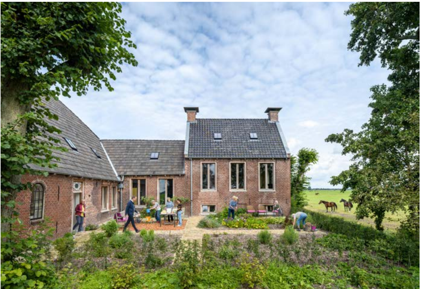
Kruidentuin met voorhuis en hals met eigentijds vormgegeven, 'verkloosterde' houten kozijnen en ramen met een bijzondere verticale geleding (foto: Thijs Wolzak)
